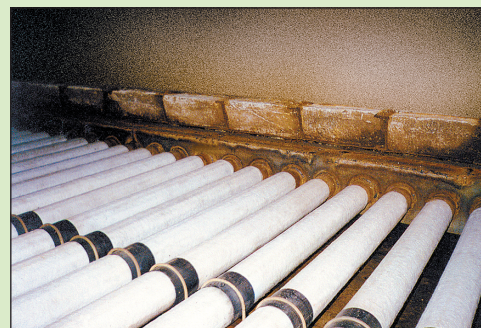
Дренажно-распределительная система скорого фильтра
