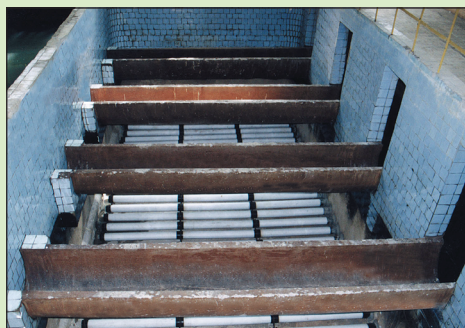
Дренажно-распределительная система скорого фильтра
